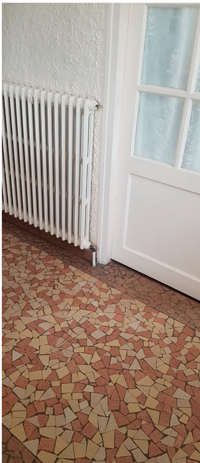
Les matériaux de sols jouent un rôle dans le stockage de la fraîcheur la nuit. Ici les céramiques en Opus Incertum d'une maison des années 1950 apportent une sensation de fraîcheur contrairement aux parquets, linos ou moquettes.
