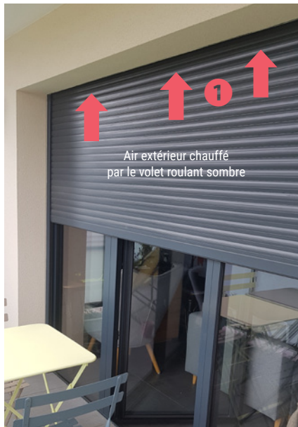
Problème de conception du volet roulant entre la chambre des parents et le balcon. 1 Le volet gris anthracite s'échauffe quand il est ensoleillé. L'air au contact du volet s'échauffe et pénètre dans le coffre du volet roulant.
