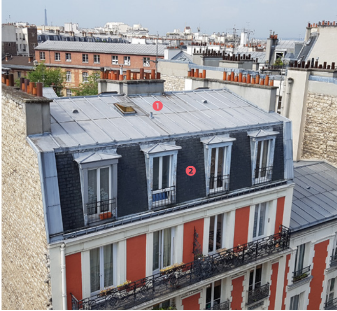
Exemple de toiture à la Mansart parisienne
