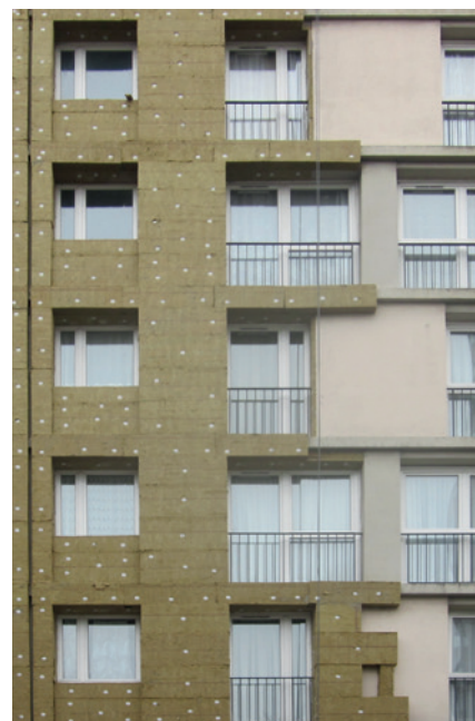
Pose d'une isolation thermique extérieure (ITE) sur un grand ensemble des années 1960. L'ITE améliore le confort d'été en renforçant l'inertie des logements.
