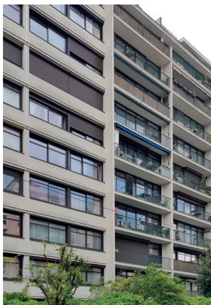
Grand ensemble des années 1960 ne comportant que des logements mono-orientés à l'Est ou à l'Ouest.
