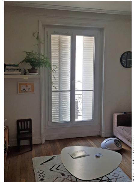
Les persiennes métalliques sont fermées pour bloquer les apports solaires, la fenêtre fermée permet d'éviter de laisser rentrer de l'air extérieur aux heures les plus chaudes.
