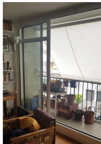
Store banne installé par l'occupante afin de protéger le balcon du soleil. Elle évite ainsi que de la chaleur ne soit stockée dans la dalle de béton du balcon.
