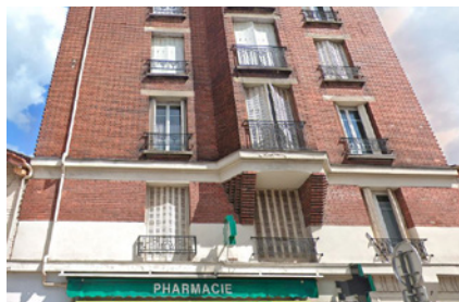
En 2022, le bâtiment en brique avant isolation thermique par l'extérieur (ITE).
