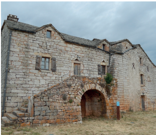
Habitat traditionnel des Causses avec des murs épais en granite. La pierre offre une inertie importante et apporte de la fraîcheur en été.
