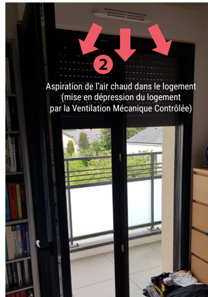
2 L'air est ensuite aspiré par la ventilation mécanique qui le fait pénétrer dans le logement.
