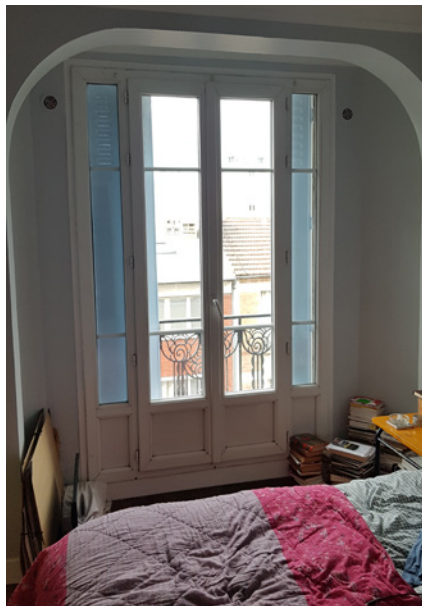
Arche en béton armé apportant de l'inertie à la chambre à coucher.
