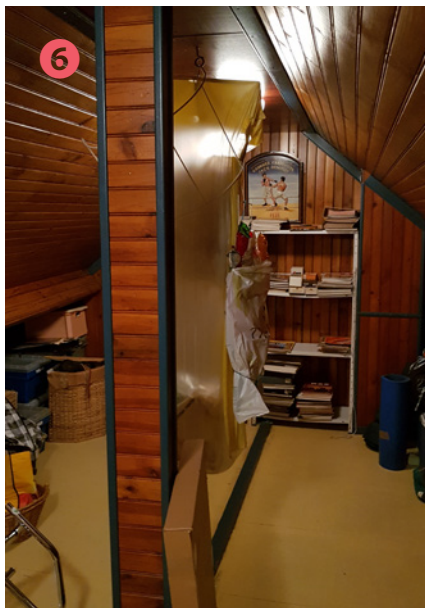
6 Grenier aménagé sous la toiture. Cet espace inhabitable joue le rôle d'espace tampon et protège les chambres des variations climatiques extérieures.
