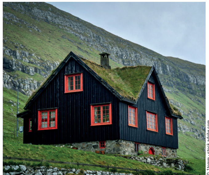
Habitat traditionnel en bois des Iles Féroé. Le bois, matériau intrinsèquement chaud, est adapté à un climat septentrional dans lequel les hivers sont rigoureux et les étés sont frais. L'usage d'un toit engazonné joue le rôle d'isolation thermique et d'étanchéité.
