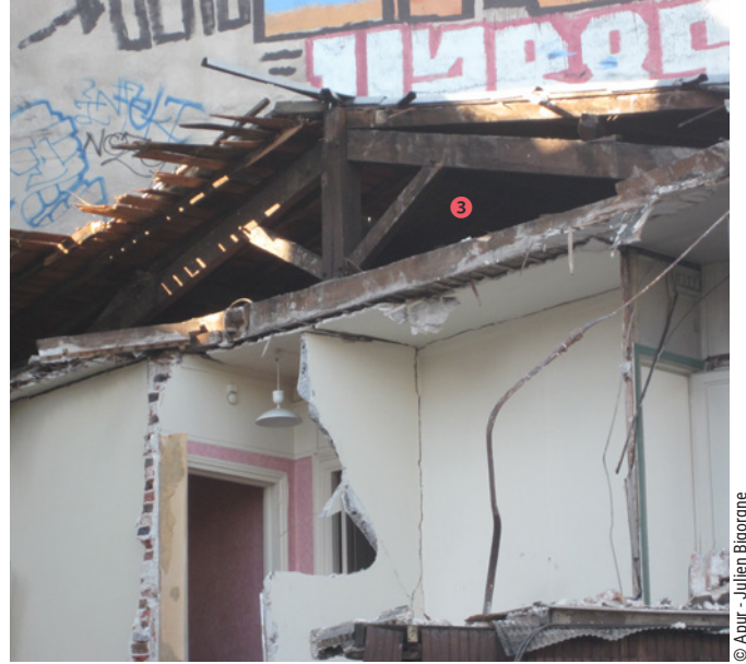
Exemple de toiture à la Mansart parisienne
